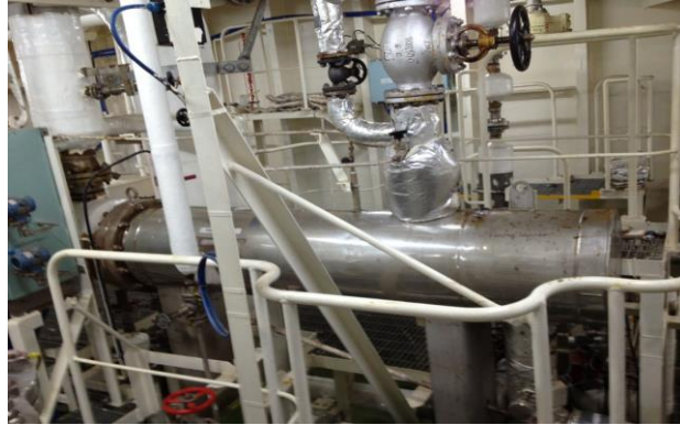
Figure 11-13 LNG vaporizer on an LNG gas carrier
